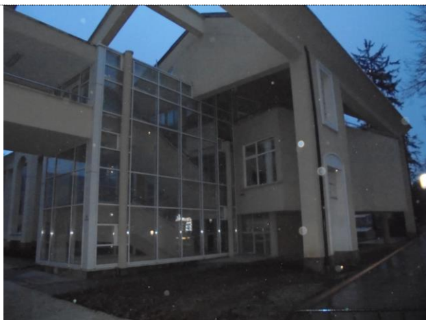
Фиг.2.8 Фасада Запад – Нова сграда
