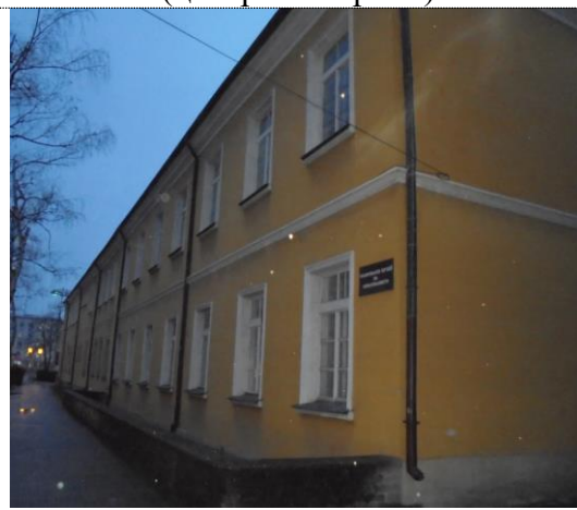
Фиг.2.9 Фасада Запад – Стара сграда (западно крило)
